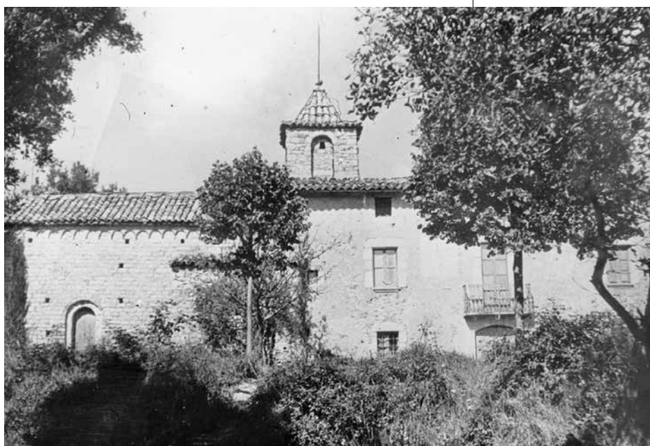
Església de Sant Cristòfol de Cerdans
